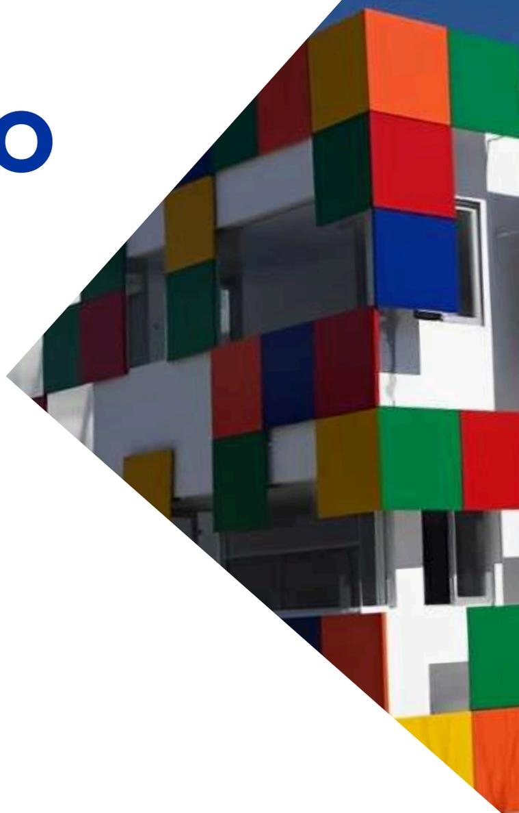
El panel de aluminio compuesto es un material de construcción ligero y versátil que se compone de dos láminas delgadas de aluminio unidas a un núcleo central de material termoplástico, generalmente polietileno. Este diseño proporciona al ACM una combinación única de propiedades que lo hacen ideal para una variedad de aplicaciones.
